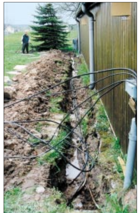
Bild 2: Wenn einmal Grabenausheben angesagt ist, dann können auch gleich noch Kabel für weitere Beverage- und mobile Zweitantennen in die Erde gebracht werden, um eine optimale Entkopplung der Kabel untereinander sicherzustellen. Im Hintergrund wartet Ben, DL5ANT, auf Hilfe.
