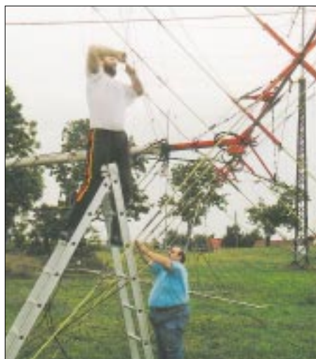
Bild 11: Ist die Antenne erst einmal unten, können alle Punkte mit Hilfe einer einfachen Leiter vom Boden aus erreicht werden. Ben, DL5ANT, und Uwe, DL5AOJ, HF-Referent von Thüringen, beim Anfertigen von 96 Knoten zur Elementbefestigung.
