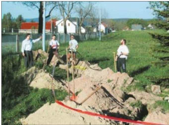
Bild 1: Nach langem Warten und viel Mühe beim Grabenausheben konnte im Mai das neue Stromzuführungskabel in die Erde gebracht werden. V.l.n.r.: Lothar, DL3TD, Steffen, DL4ALB, Rainer, DL1AUZ, Ben, DL5ANT
