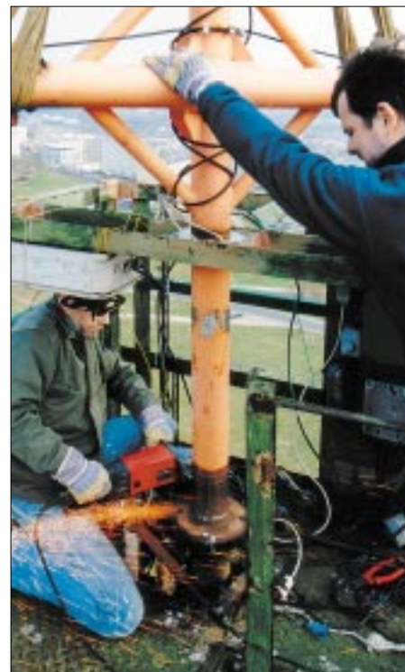
Bild 6: Rainer, DL1AUZ, und Steffen, DL4ALB, trennen am Fuß des Standrohrs der 3-El-40-m-Quad das angeschweißte, teilweise zahnlose Zahnrad ab, während die Gurte des Krans diese Prozedur stabilisieren. Die in 30 m Höhe liegende Plattform für diese Antenne erlaubt immer wieder einen schönen Blick nach Ilmenau, hinein in der Thüringer Wald.
