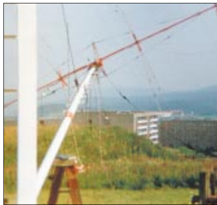
Bild 8: Die 27 m hohe 3-Band-4-El-Quad war und ist das langjährige Ilmenauer Flaggschiff. Im vergangenen Jahr mußte auch diese Antenne vollständig überholt werden. Nach rund 22 Jahren zuverlässiger Arbeit hatte ein Pflegefehler im Klub für Aufsehen gesorgt und schnelles Handeln verlangt.
